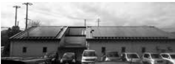
たけのパーク屋根の太陽光パネル
