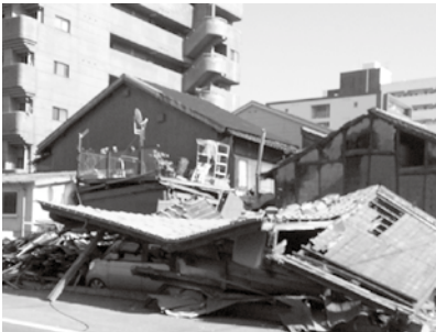
熊本・倒壊家屋
